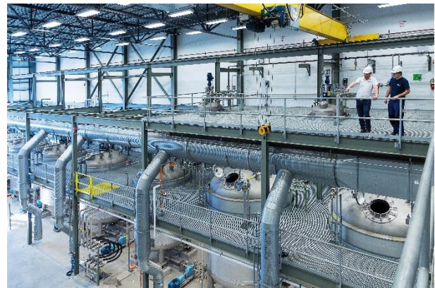
Abb. 2: 75% der Montagearbeiten finden mittlerweile in den Werkshallen statt.
